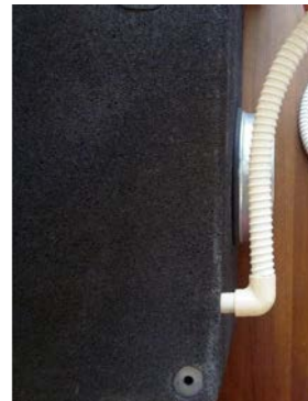
Inserimento del tubo scarico condensa (a carico dell'installatore)
