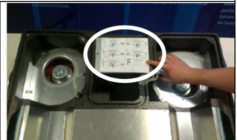
Rimuovere i filtri e successivamente le staffe metalliche di bloccaggio.
