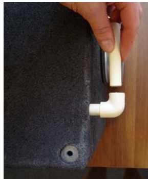
Collegamento dello scarico condensa della macchina con il gomito 90°.
