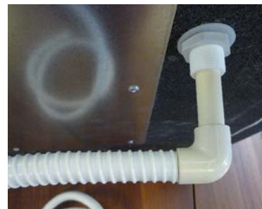
Inserimento del tubo scarico condensa (a carico dell'installatore)
