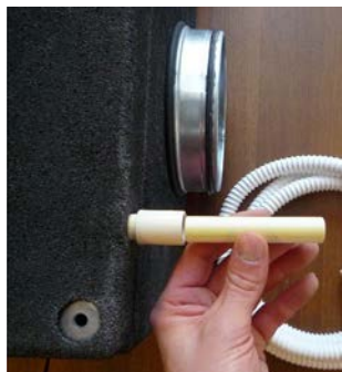
Collegamento dello scarico condensa della macchina con un manicotto dritto.
